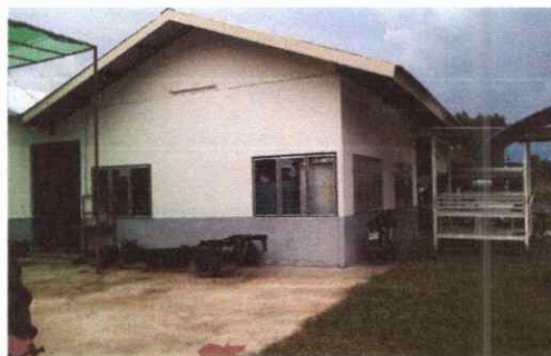
รูปที่ ๙ อาคารหลังที่ ๗ อาคารเรียนปฏิบัติช่างกลโรงงาน
